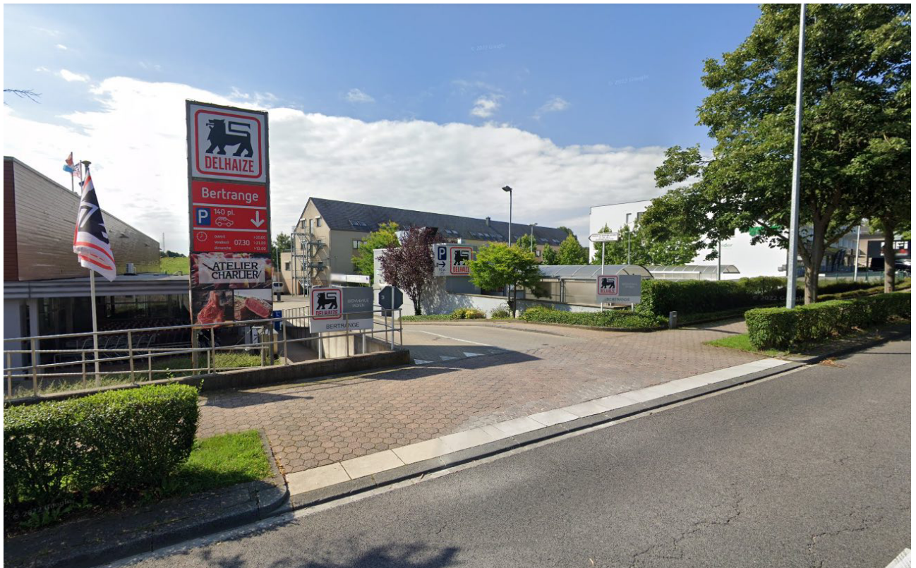
Abb. 5: Straßenansicht des vom geplanten Umbau betroffenen Gebäudes des CDV, links der Supermarkt, rechts der Elektromarkt (Quelle: Google Streetview, 2021)
