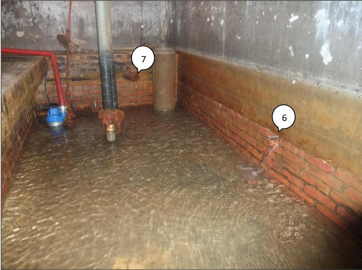
*Bild 3: Zufluss 6 und 7 und Pumpen.*
