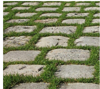
Pavés non jointés avec gazon
