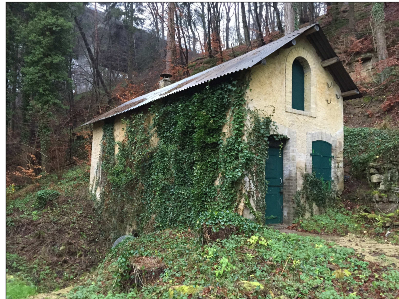
Abb. 2: Blick auf das Gebäude mit Quellstube im Untergeschoss.
