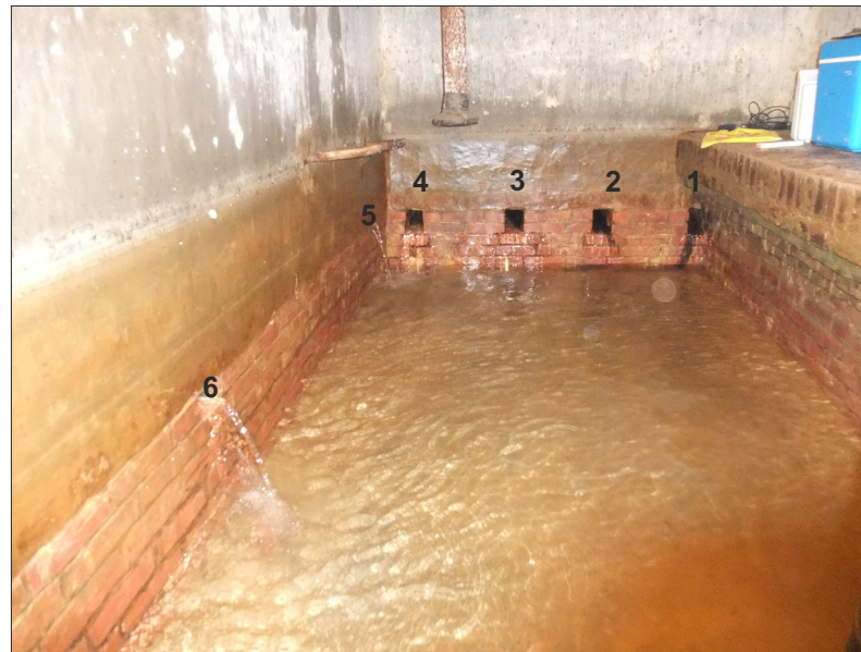
Abb. 3: Blick Richtung Südosten.
