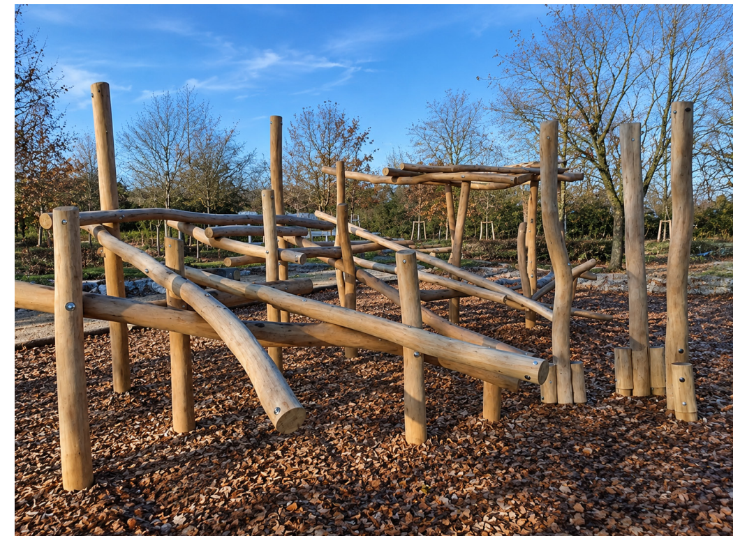
5_ Nid en construction, structure d'équilibre
