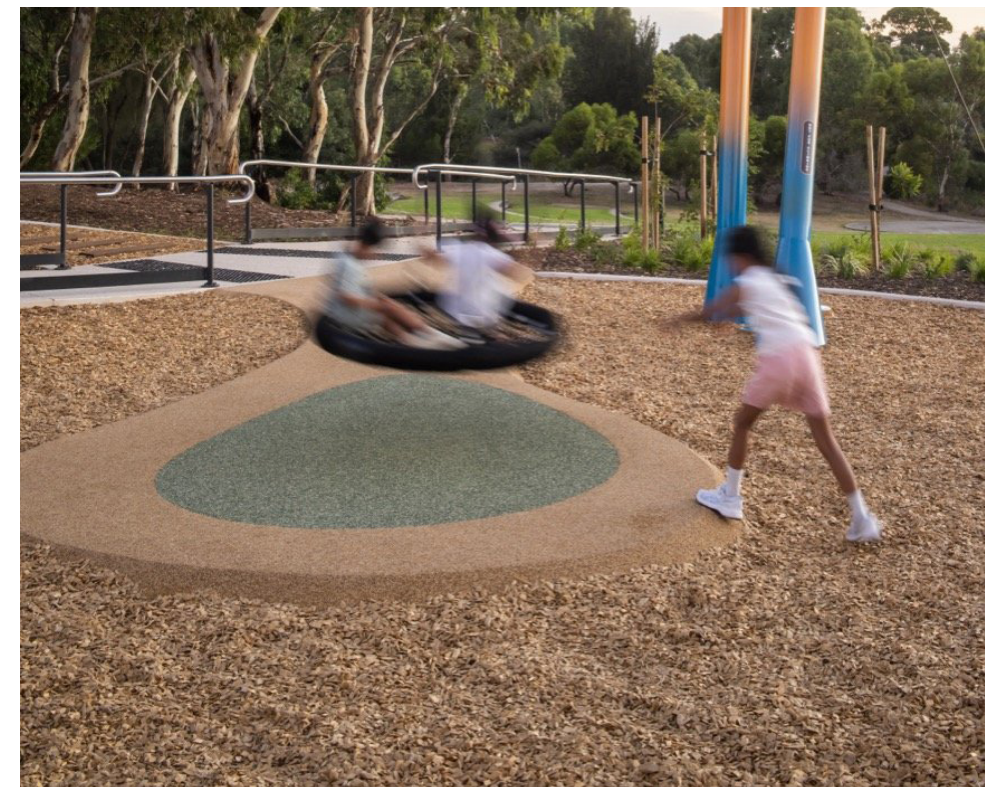
Sol EPDM teinte naturelle, avec touches de couleurs
