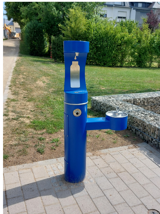
Fontaine à eau existante
