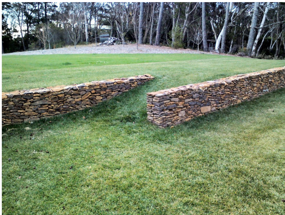
1_ Murs de soutènement en pierre naturelle
