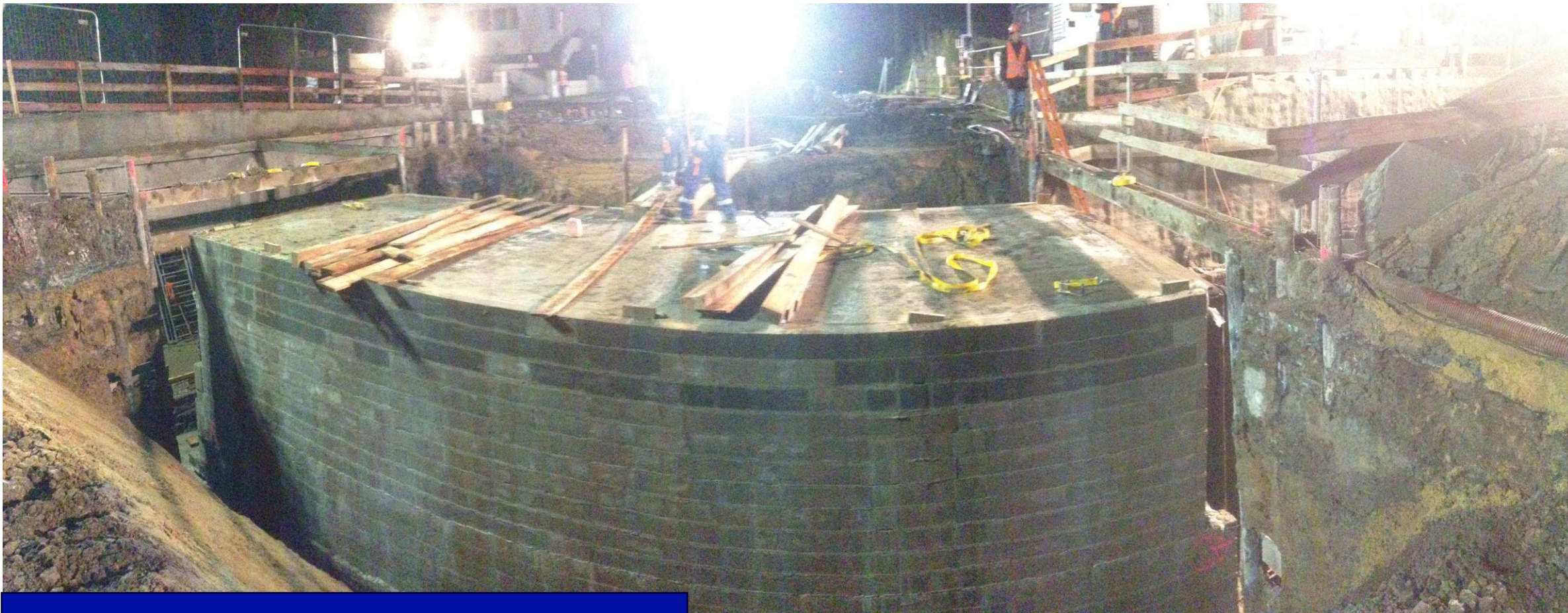
Exemple: Ripage sous voies ferrées à Livange
