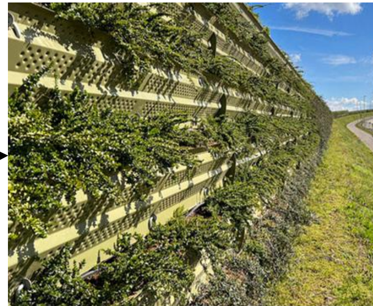
Beispill vun enger vegetaliséierter Schallschutzwand (Dimensiounen: 18.00m laang 3.00m héich)
